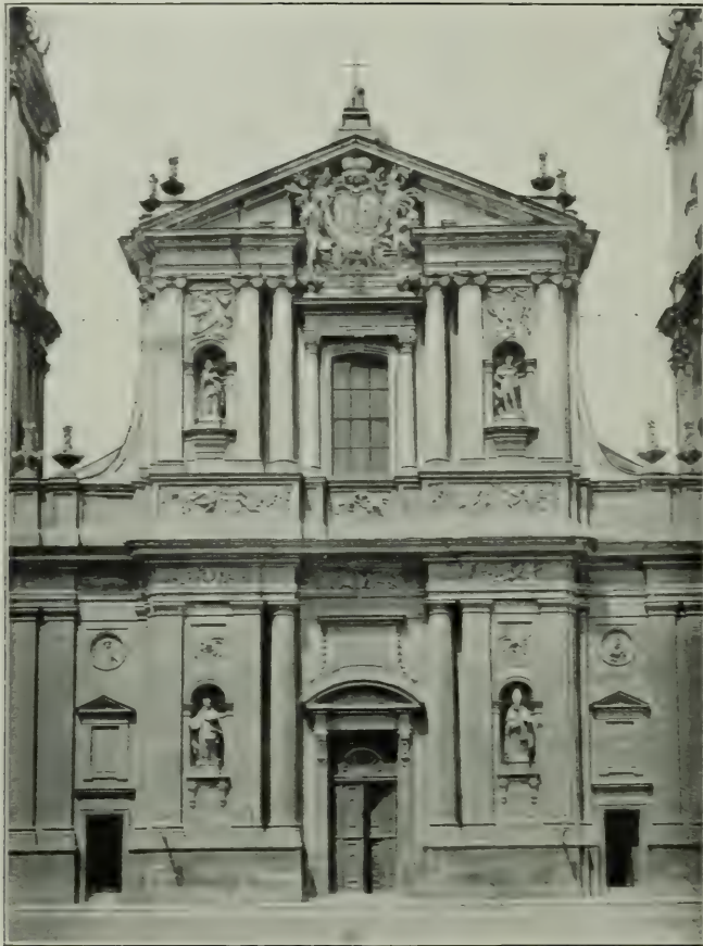
Eglise des Théatins. Détail de la façade.
